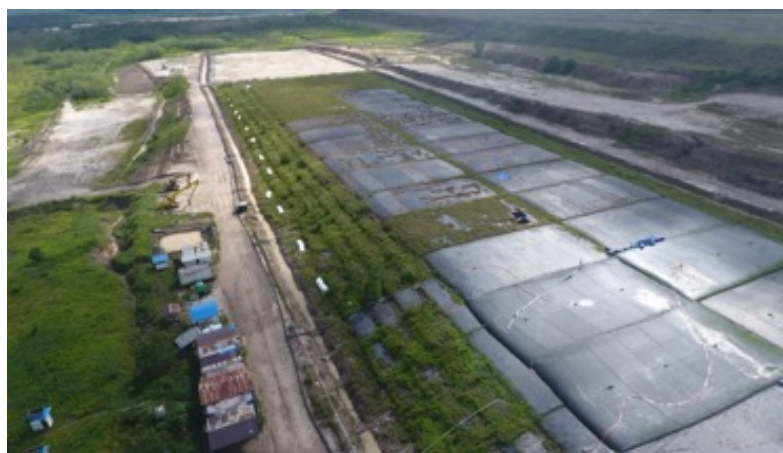
Mud treatment using the Adatube technology | Pengelolaan lumpur menggunakan teknologi Adatube
